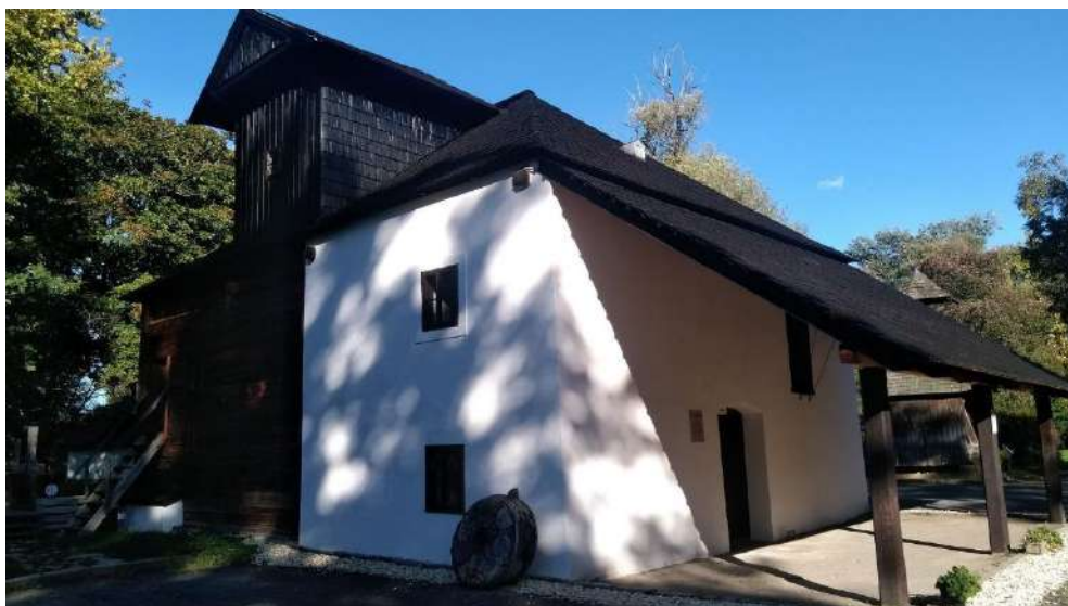
A felújított Hencz-malom
