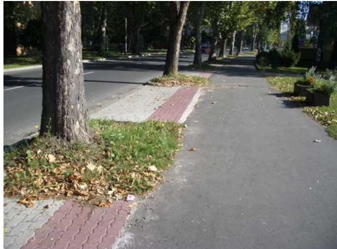
K-i oldali fasor 20-21. sz. fájánál a parkolóhelyek kialakítása. A 20. sz. fánál a járda aszfaltburkolatát a fa gyökerei felemelték.
