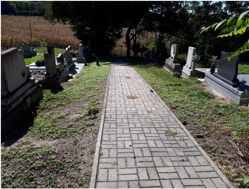
Felújítás előtti állapot
